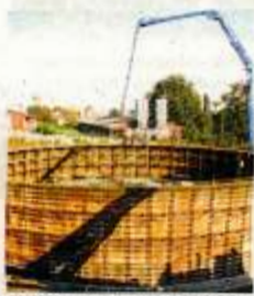
Stavba bioelektrárny už je v plném proudu. Foto: Pavel Bohun
