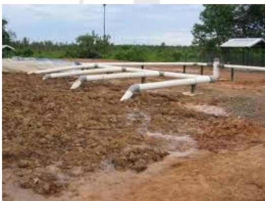
Obr. 3 Halda vedená v režimu techniky biopiling, která je vhodná pro zpracování ropou znečištěných zemín
